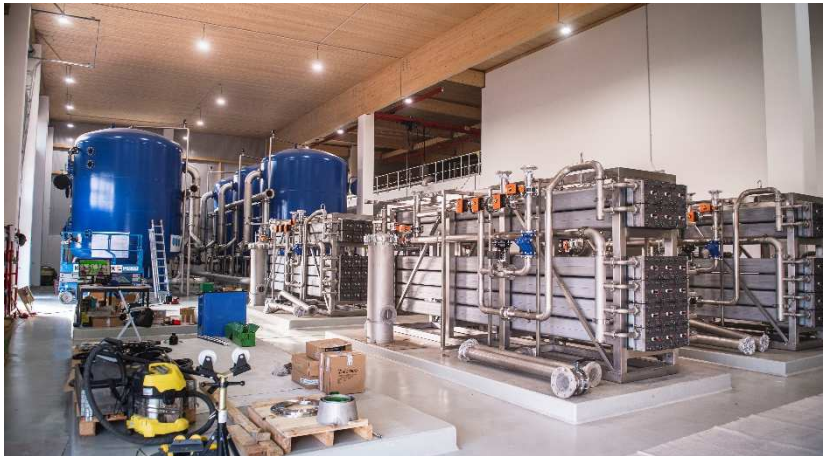
Membraneinheiten, im Hintergrund Aktivkohlefilter
